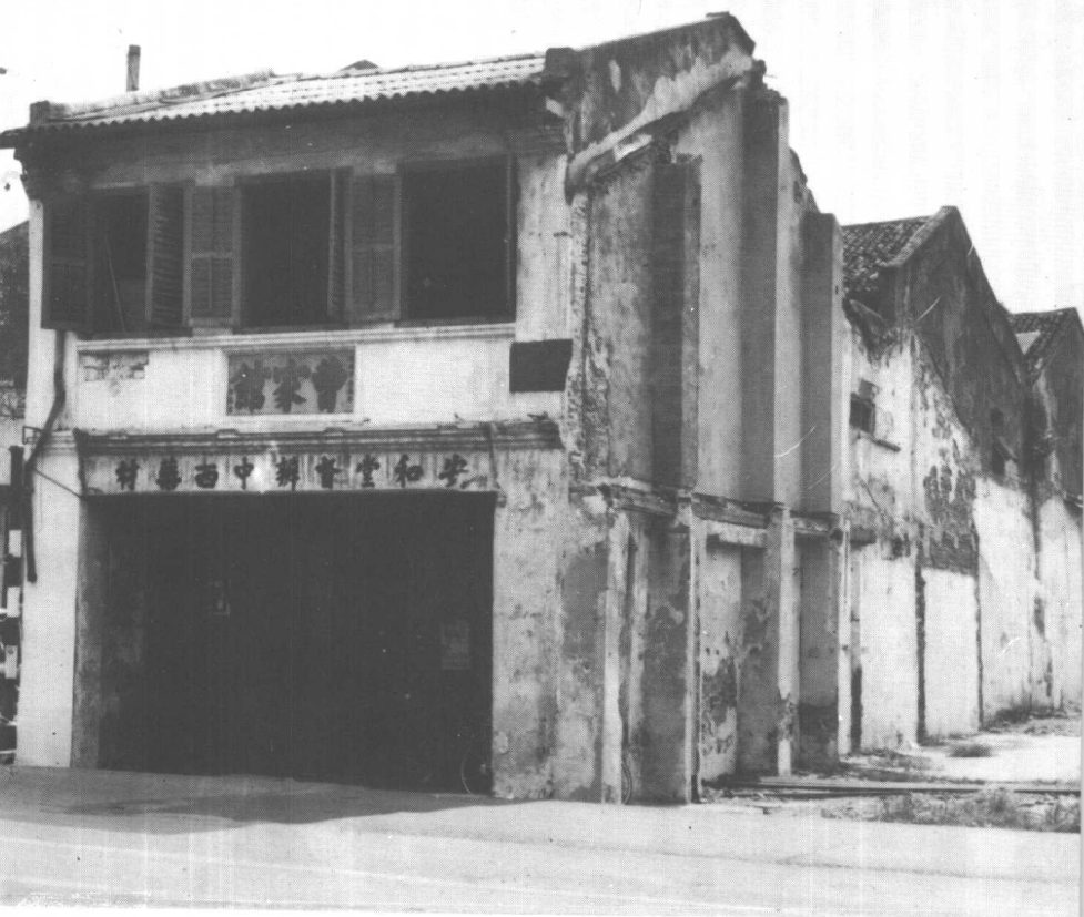
个已拆除的曹家馆舍。
