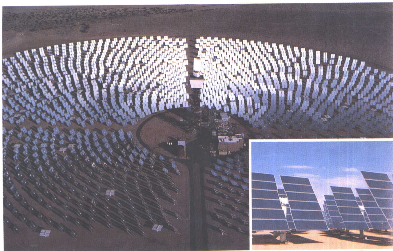
14. 建造在美国西部的太阳能发电站,最大输出功率 10 万千瓦。反射镜的朝向用电子计算机控制,把太阳光反射到集热器上。
