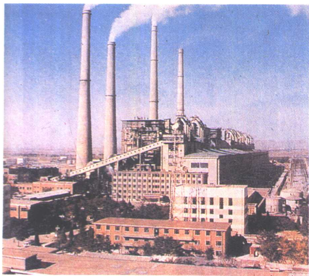
7. 河北陡河火电厂,总装机容量 155 万千瓦,
