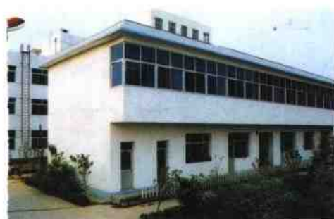
公司安全用具开关车间一角
