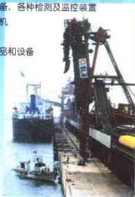
秦皇岛煤码头三期工程
