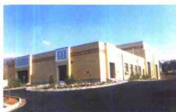
伊朗德黑兰地铁 AEAD63/20kV 变电站外景
