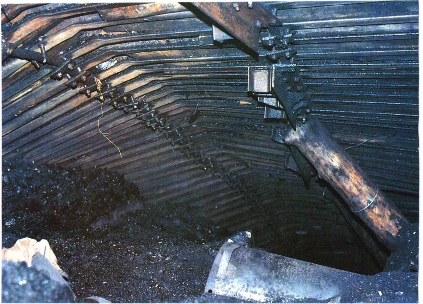
淮南矿务局李一矿使用柔性掩护支架采煤工作面
