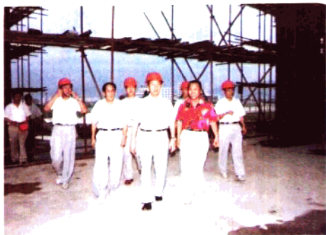
● 省委书记卢荣景等来开发区“国泰商业花园”施工现场指导工作
