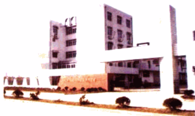
● 恒安仓储实业有限公司写字楼
