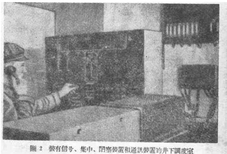
圖 2 裝有信号、集中、閉塞裝置和通訊裝置的井下調度室
