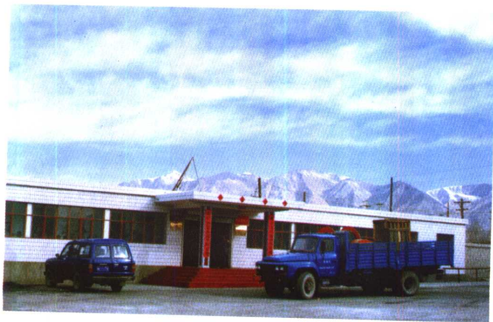
海西州大头羊煤矿矿部
