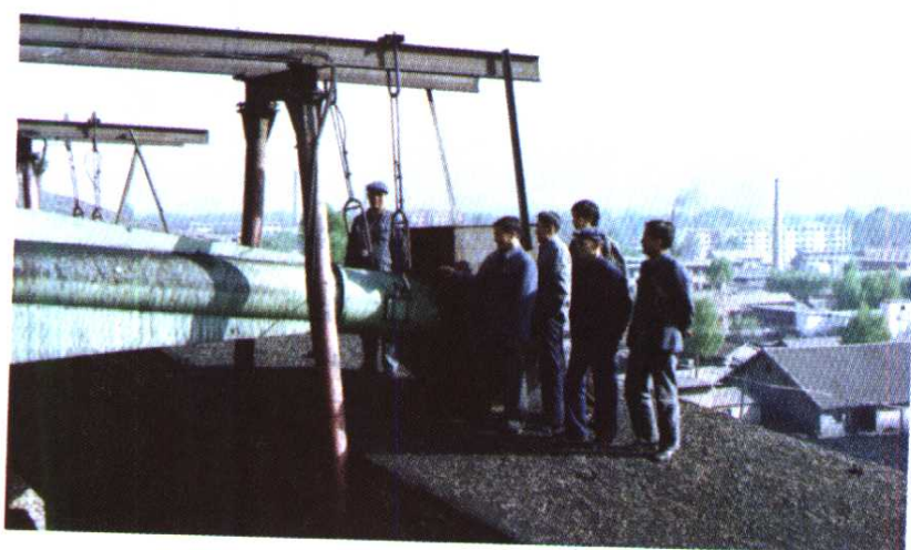
风力选矸机在大通局投入使用，技术人员正在观察选矸情况
