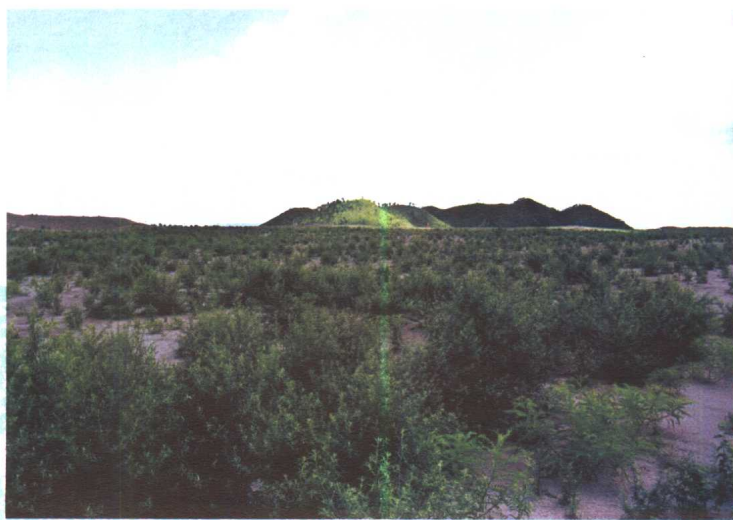
首钢水厂铁矿尾矿库植树无覆土种植沙棘、 紫穗槐已是绿色一片
