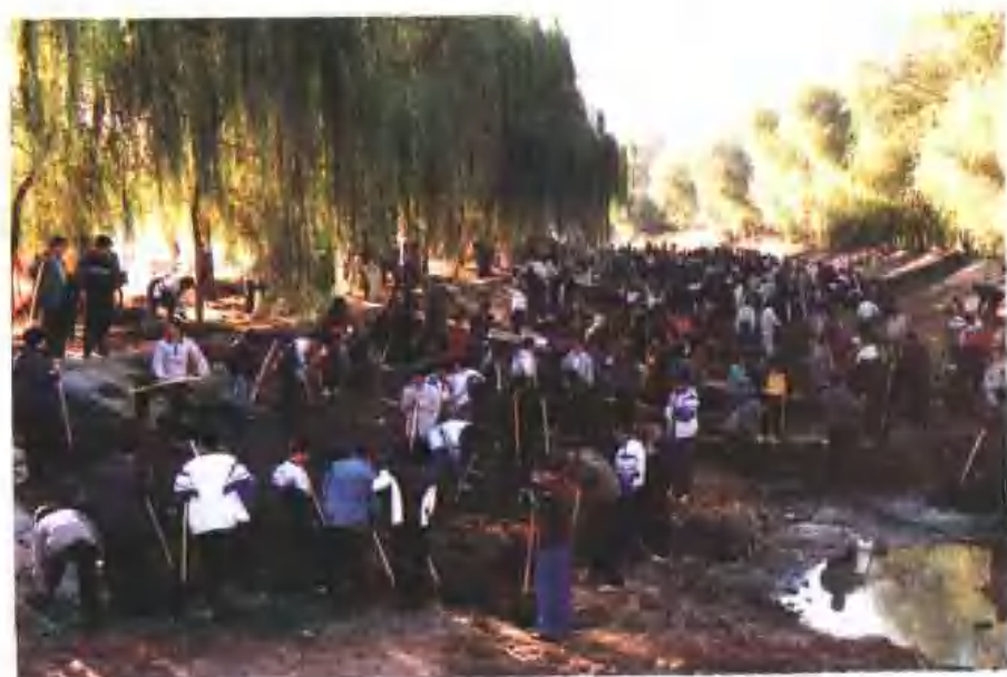
小泉河、怀河治理工程
