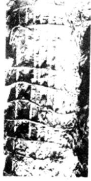
图7 露筋桩
