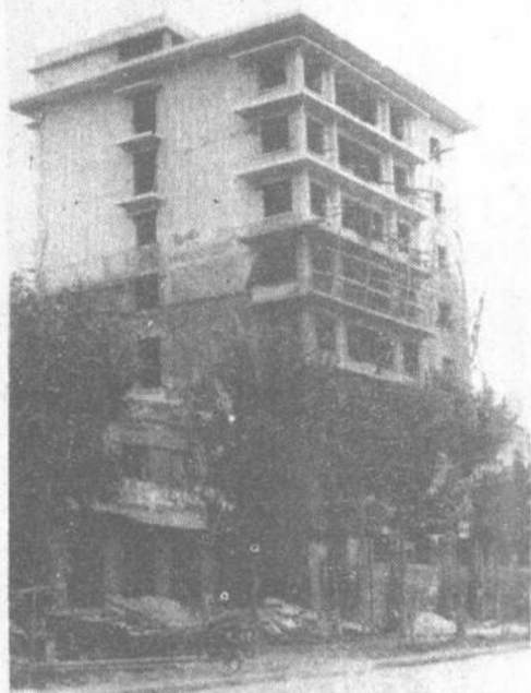
图 1-11 加设构造柱的唐山新华新旅馆 经10度地震后安然屹立
