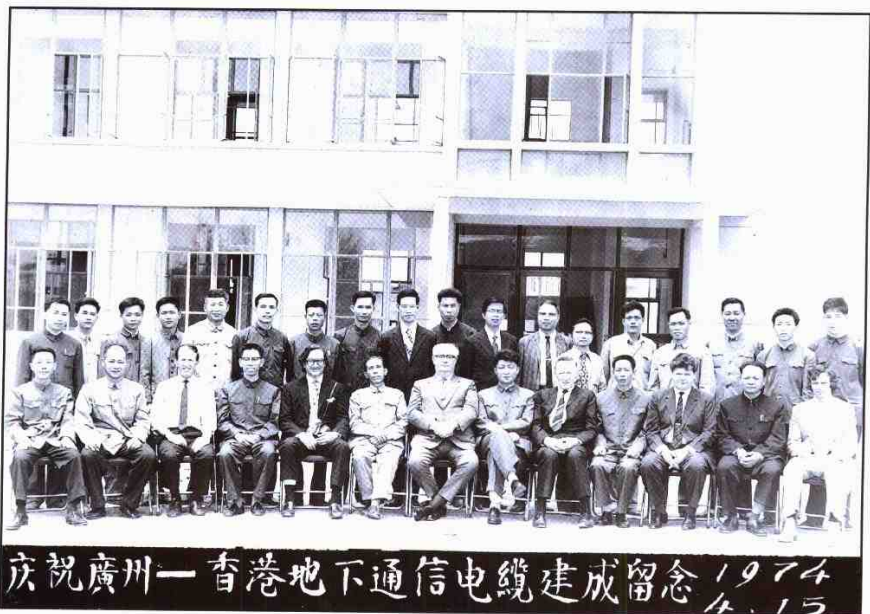
周恩来总理批示“速办”的广州—香港地下通信电缆工程（“411”工程）之宝安电信大楼落成时粤港参与建设人员合影（1974年4月15日）
