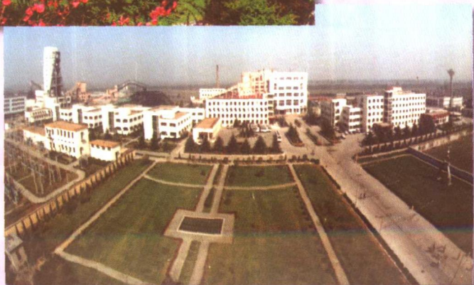
济宁二 号煤矿全景
