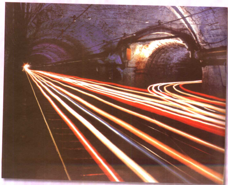
兖矿集团南屯矿标准化大巷
