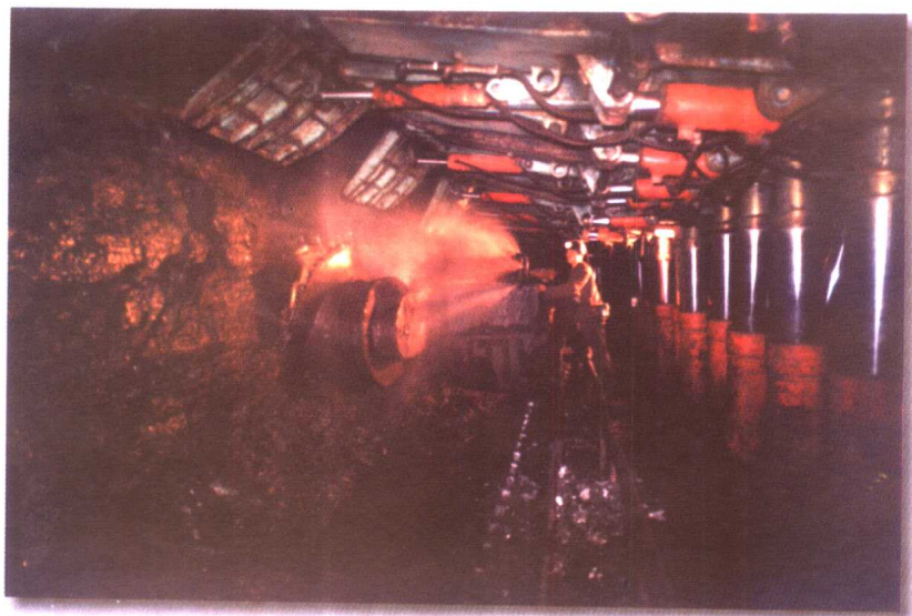
兖矿集团兴隆庄矿综放工作面
