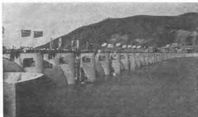
這是黃山頭節制閘。閘門面前是虎渡河水。這個新建的大閘控制着河水永遠保持着三千八百秒立方公尺的流量。
