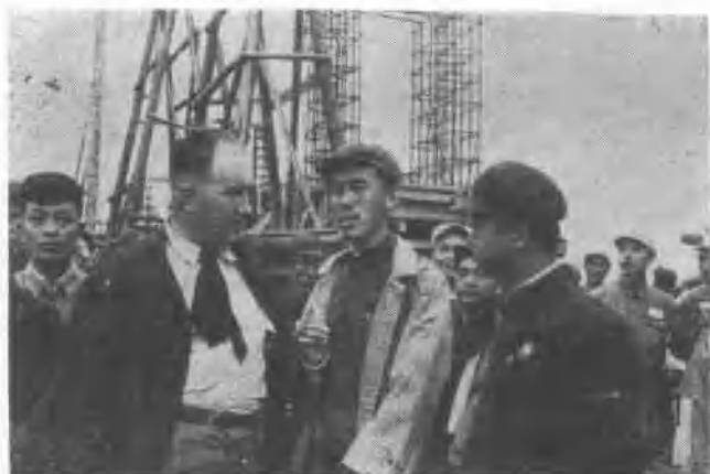
工程進行中，得到蘇聯水利專家布可夫同志熱心幫助，並介紹了許多先進的經驗。圖為布可夫同志在進洪閘工地與我工程人員研究工作。
