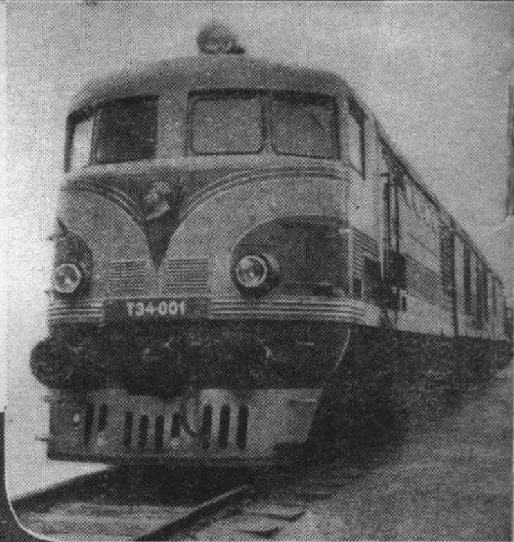
右：哈爾科夫運輸機器製造廠出品二千匹馬力新式煤氣內燃機車。
