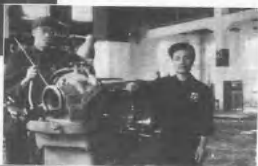
(下) 在蘇聯「紅色無產者」工廠製造的1A 62車床上表演車削車床主軸。切削速度300公尺/分鐘，精車時生產效率提高了45倍。
