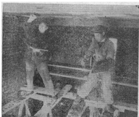
抹砂子灰的互助組正在抹天棚
