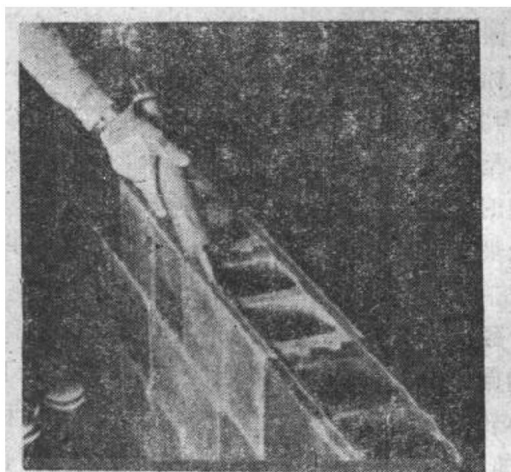
图 2 正在用灰浆枪在铺灰
