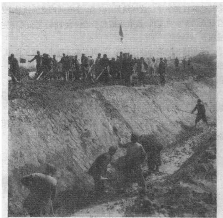
結合兴修水利, 开新沟, 填旧沟, 埋釘螺
