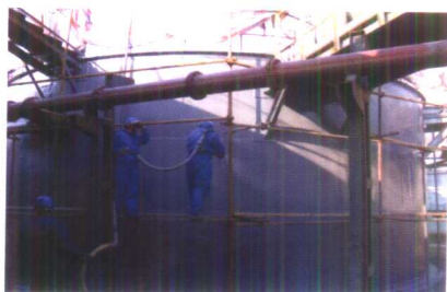
图 20-7 SPUA 技术施 工罐体侧壁
