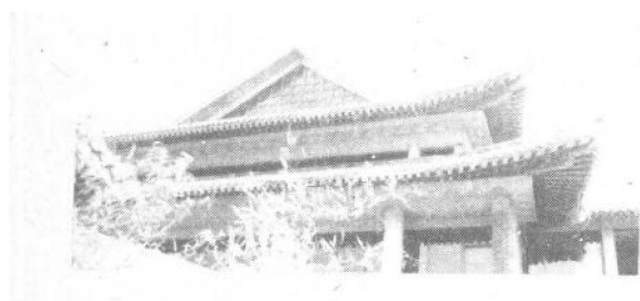
图3 闾里宾舍门厅上头的十字脊重檐瓦顶。它是在钢筋混凝土薄壳上蒙了瓦面。檐下的椽子是用混凝土塑成的
