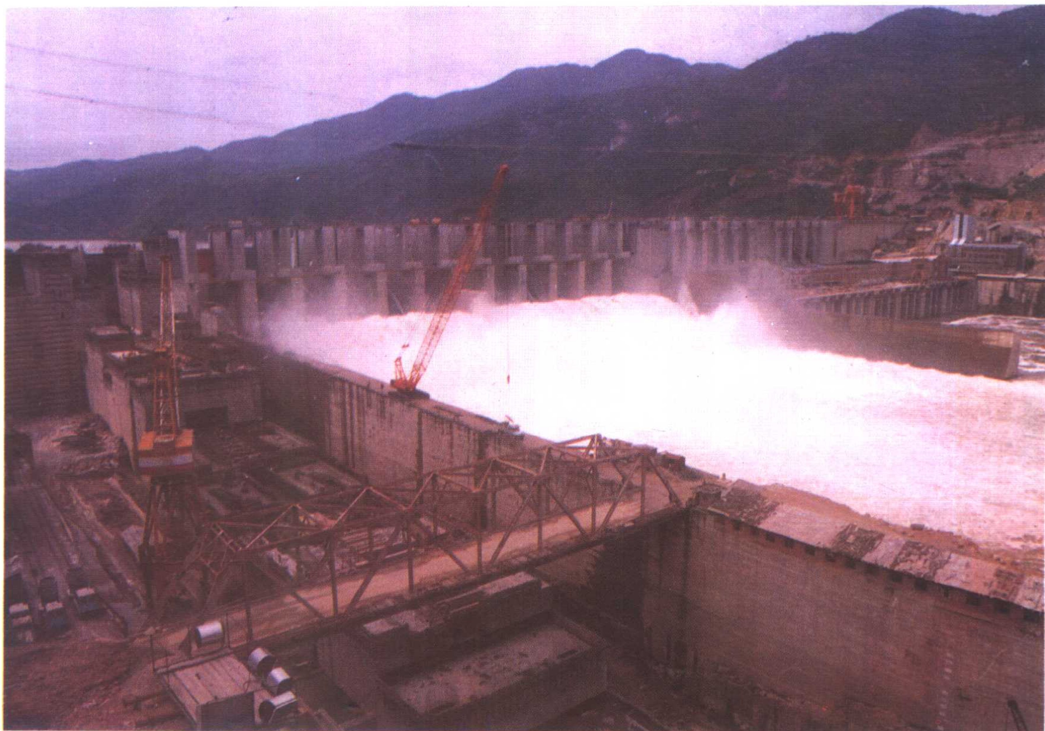
华东最大水电站——水口电站建设中
