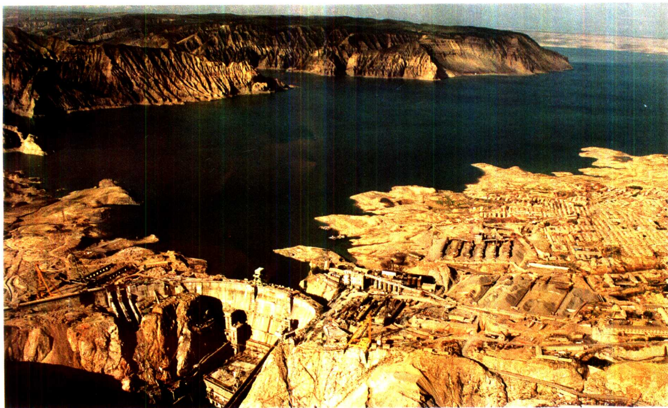
龙羊峡水电站及水库鸟瞰图
