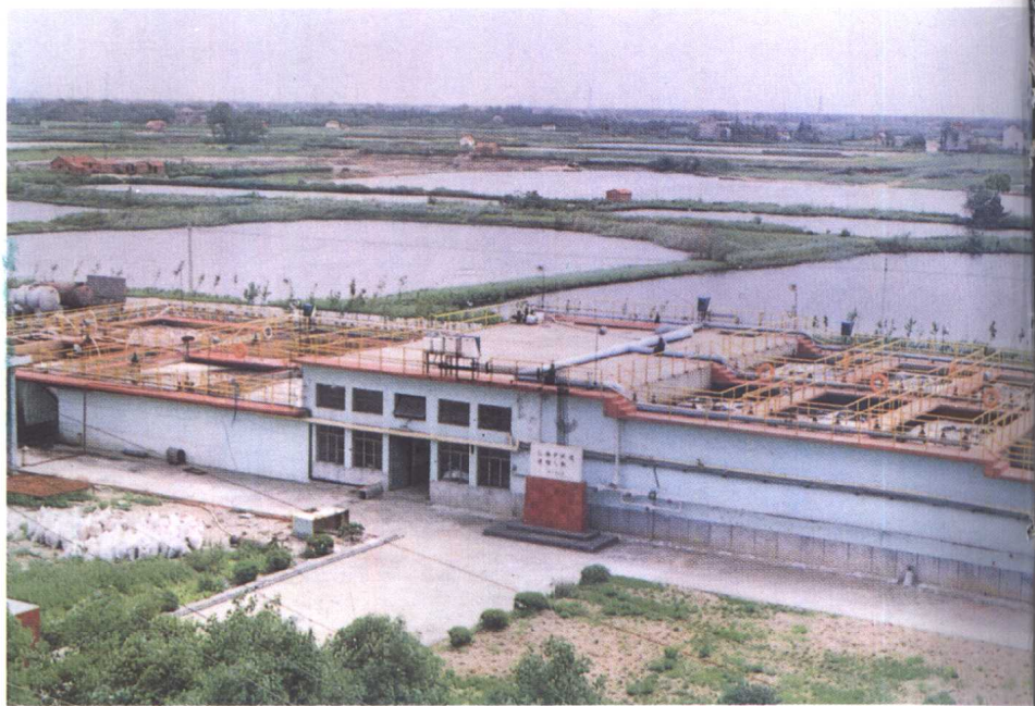
昆山市制药厂污水处理设施。
