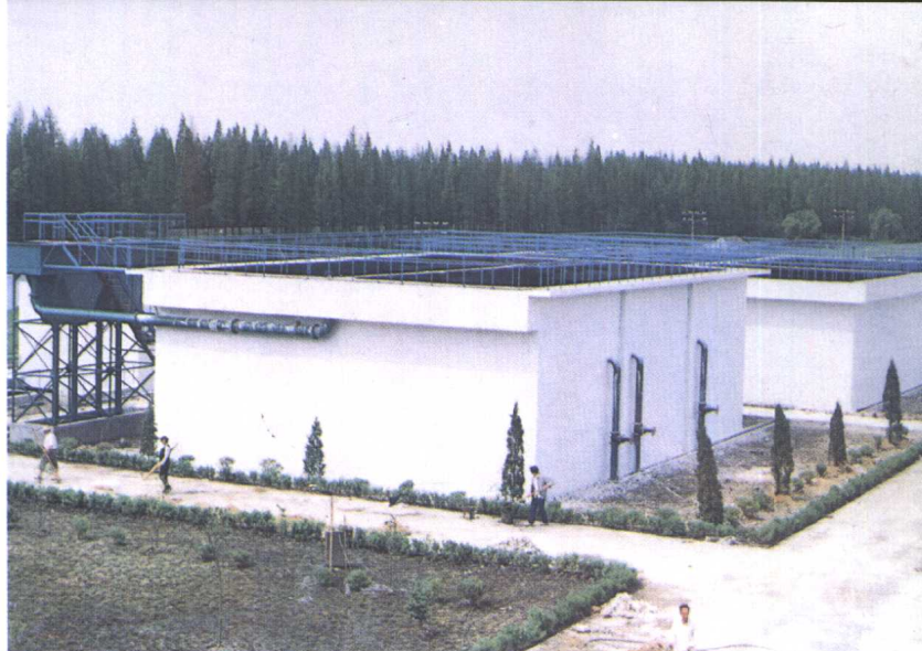
正仪镇污水处理厂外景。
