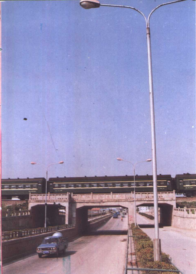
昆山市区长江路上的铁路、公路立交桥。
