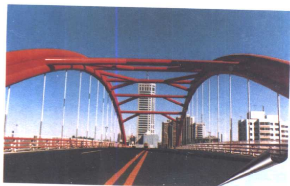
金钢桥改建工程
