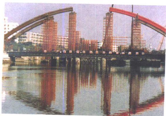
金钢桥改建工程
