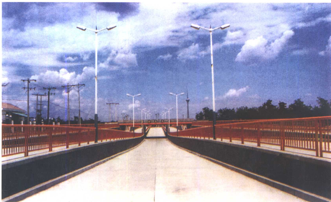
宾水道跨铁路地道桥
