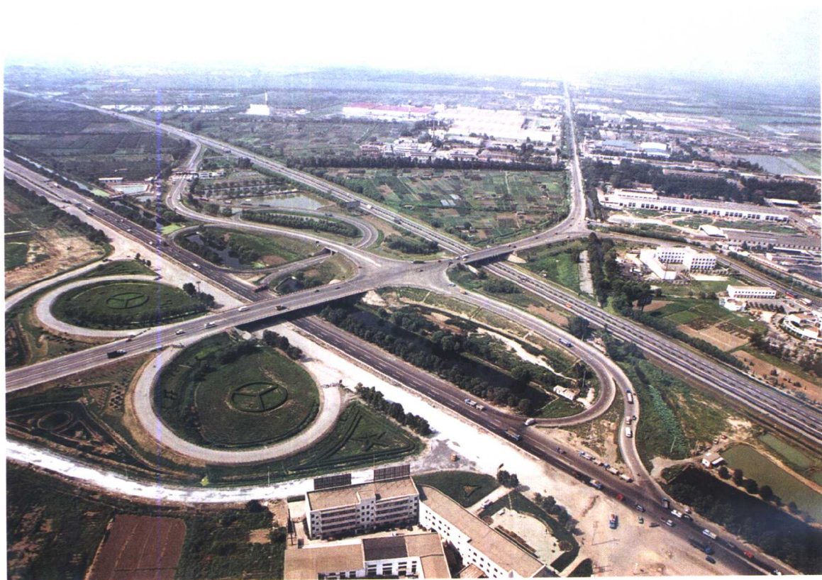
市区环射状干道网工程—外环线与京津塘高速公路交口
