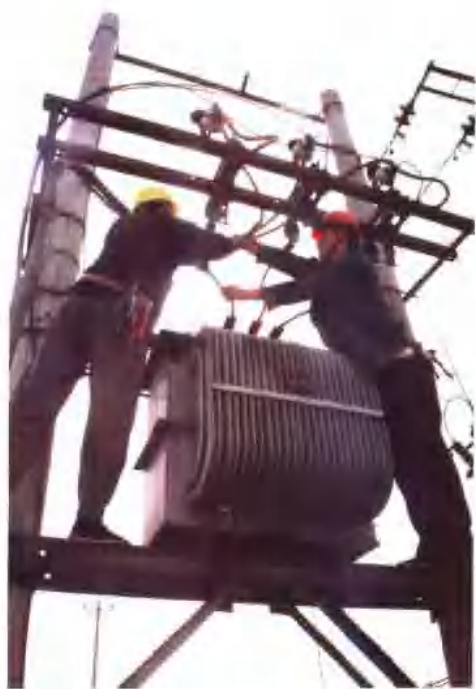
工人正在为全村电增容施工。
