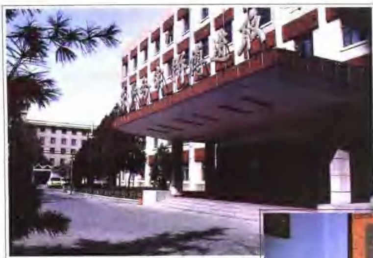
北京矿务局机关办公楼
