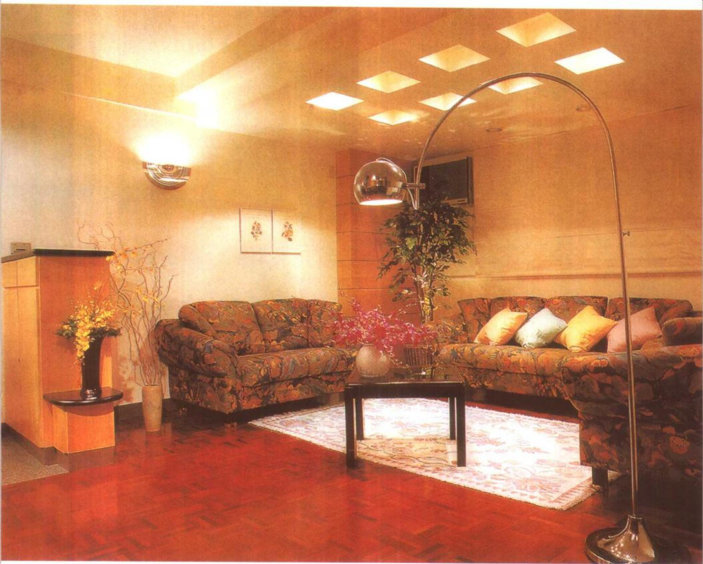
墙壁上半圆形的壁灯，以上照的方式利用天花反射出来柔和的光线，补充光度不足的暗位，属间接照明。作凹嵌式的格状天花，装上射灯，具有背景照明的功能
