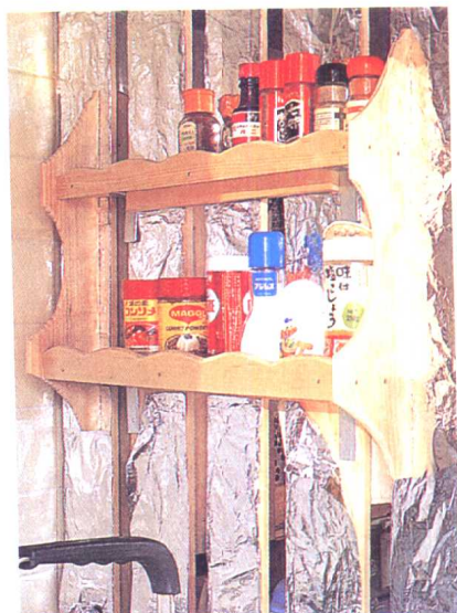
▲ 炉灶和操作台由木架柜分隔开，在炉灶一侧为防止弄脏而贴上锡箔纸，并钉上调味料架，便于烹调时取用。
