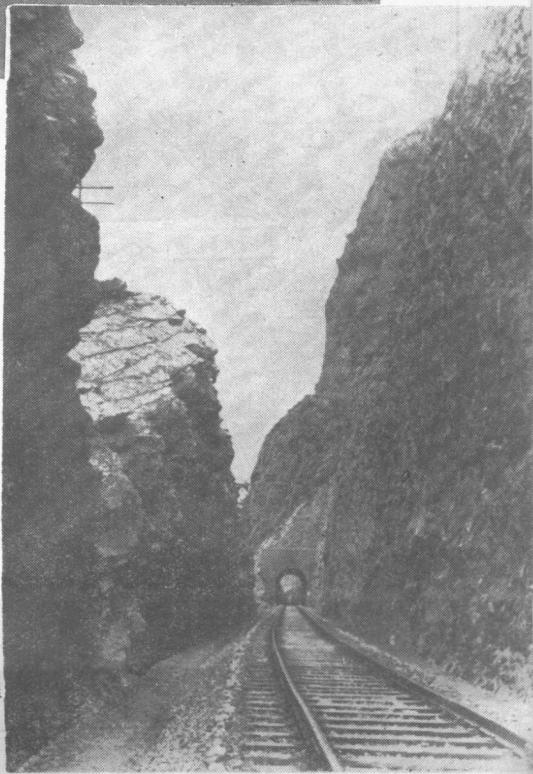
明月峡危险的挖方工程
