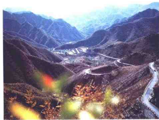
分局承建的张宝公路
