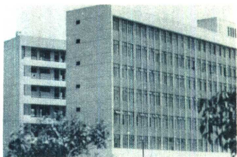
福建医科大学 基础教学主楼
