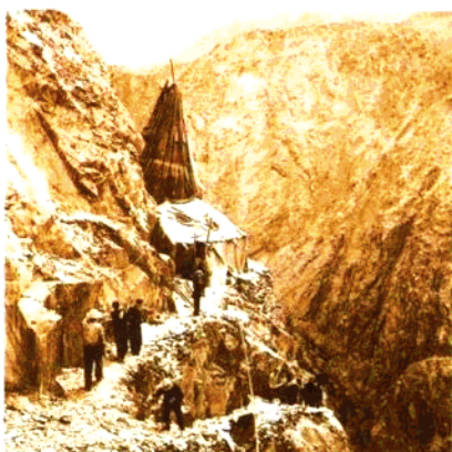
在三峡工程地质探区
