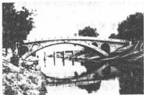
图 1-1 河北赵县赵州桥 (公元 605 年)
