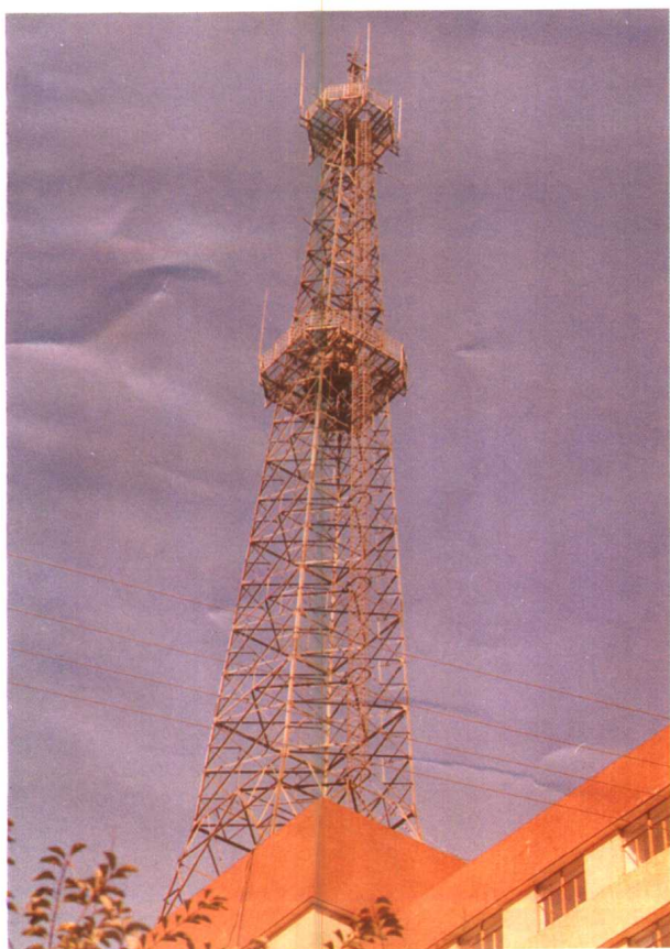
彩图2-4-14 钢楼梯用于电讯铁塔 (上海刑事科学技术研究所)
