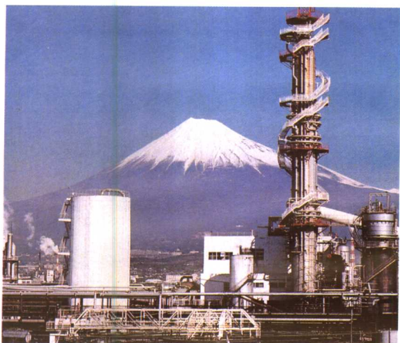
彩图2-4-20 中柱式悬挑钢楼梯用于室外工业设备之一(日本工业)
