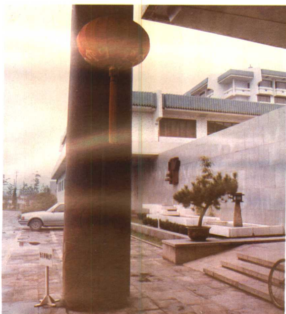
彩图2-1-3 入口台阶, 靠花坛边设有坡道, 便于残疾人轮椅及行李车上下 (杭州黄龙饭店)
