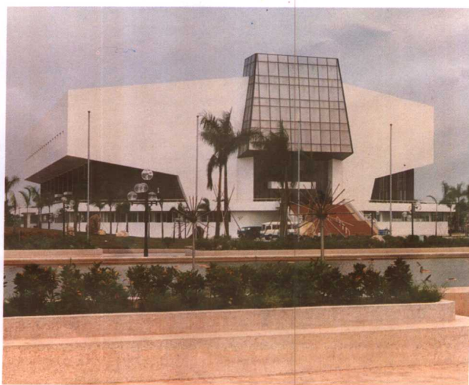
彩图2-1-34 室外大楼梯之二 (广州体育中心游泳馆)
