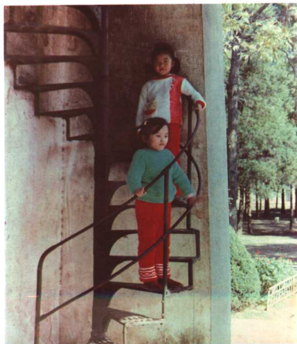
彩图2-4-17 中柱式铸铁悬挑踏板旋楼梯用于室内便梯 (南京鸡鸣寺钟楼)
