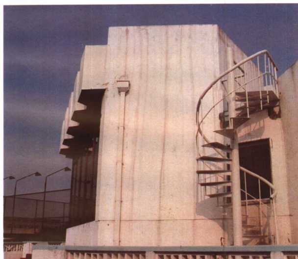
彩图2-4-16 中柱式钢悬挑踏板旋楼梯为室外竖向交通 (山东济南齐鲁宾馆)
