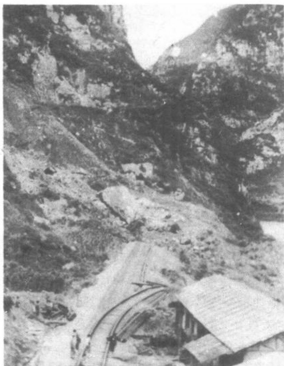
图 1—4 宝成线鲁光坪崩塌性滑坡图
