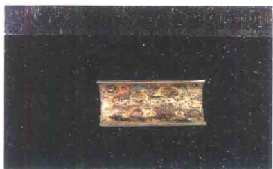
5-7 白铜管停用腐蚀引起的脱镍
