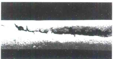
5-9 凝汽器管的汽侧冲刷损坏
