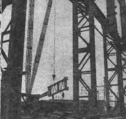
在鞍鋼的工地上，已採取機械化施工方法。上圖是三十噸的起重機正吊起鋼架。
