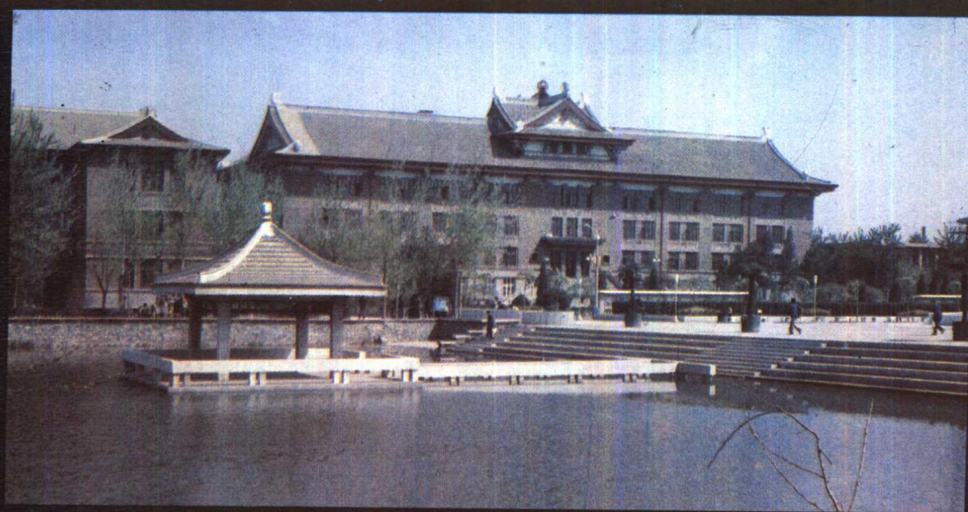
天津大学九楼全景
