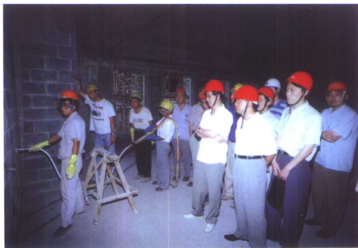
舒布洛克公司工程人员在中国建筑文化中心大厦向外墙夹层中注射美国发泡保温材料。该大厦北塔楼是建设部建筑节能示范工程。建设部叶如棠副部长(图中右起第6位)正视察指导施工。
