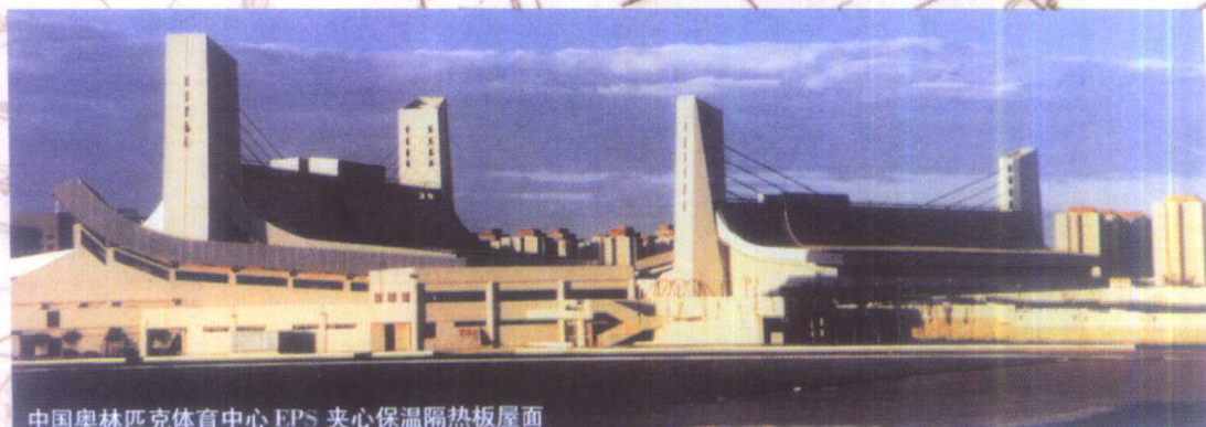
中国奥林匹克体育中心 EPS 夹心保温隔热板屋面
