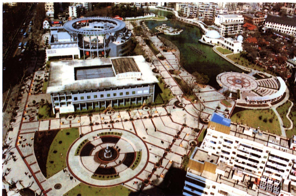
山西路市民广场(全景)
