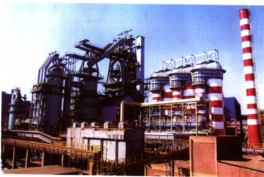
首钢为津巴布韦钢铁有限公司设计建造的高炉
