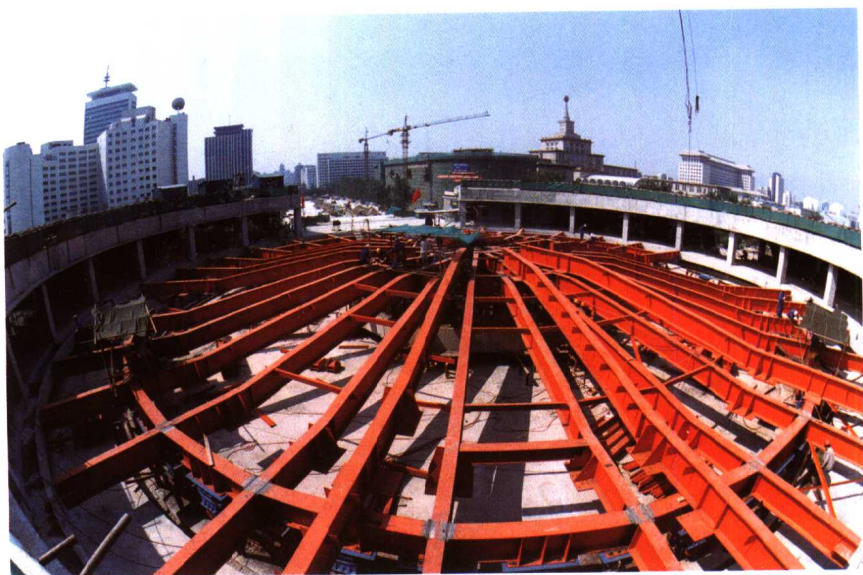
首钢承建的中华世纪坛旋转圆坛工程
