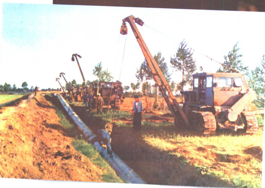
铺设输油管道
