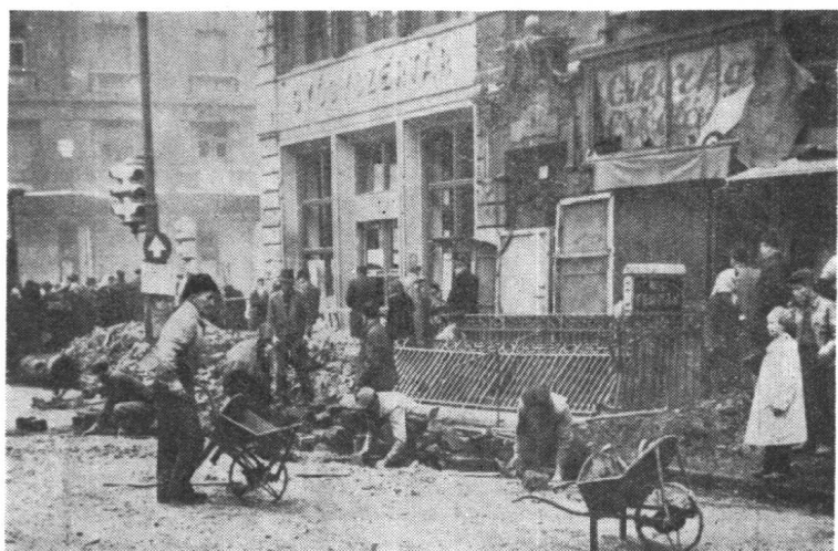
布达佩斯的工人们正在修复被破坏的街道。
