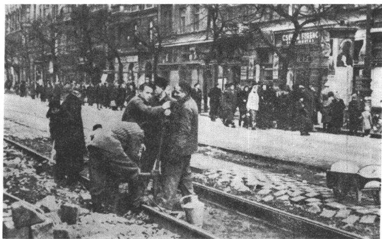
布达佩斯的工人们正在修复电车轨道。
