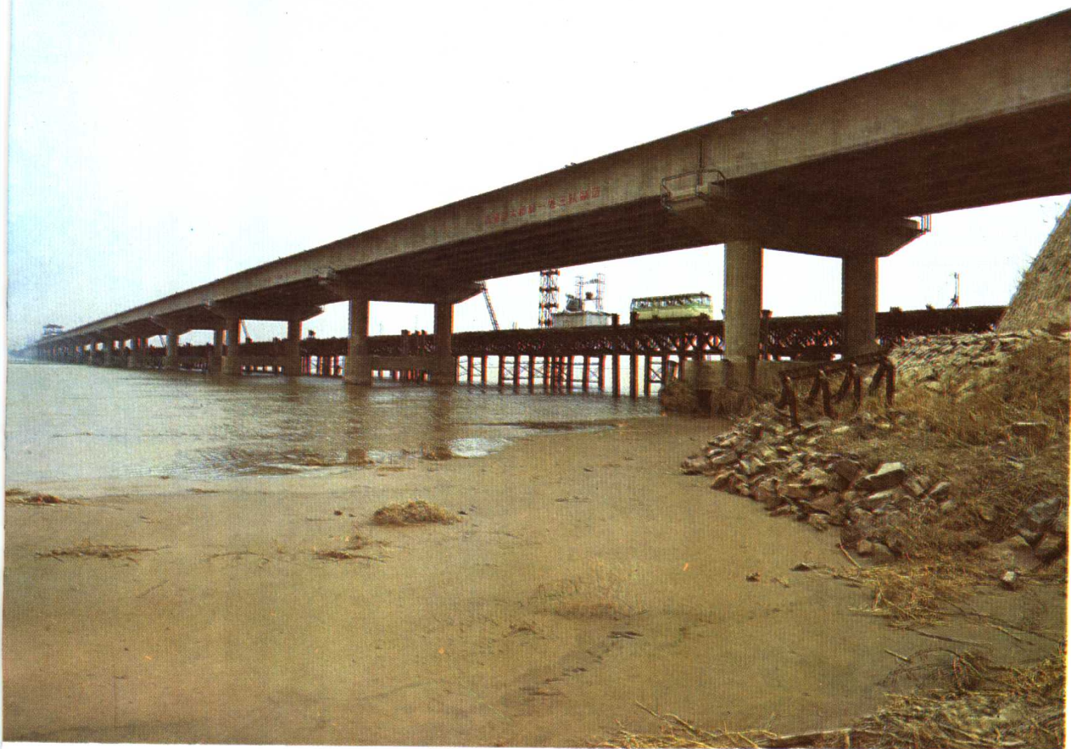
黄河公路大桥
