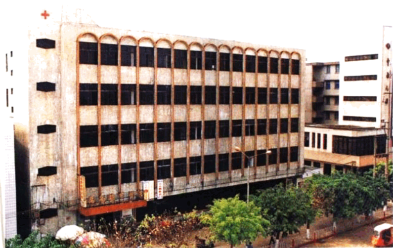
图为临高县中医院门诊大楼
