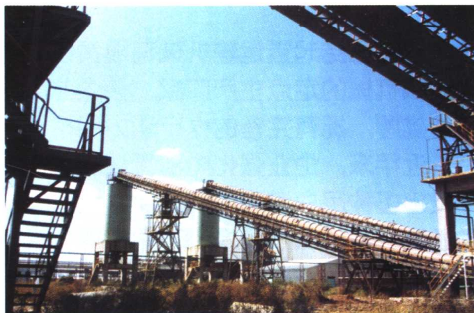
我厂为首钢2号高炉制作的上料和配料胶带输送机的外景
