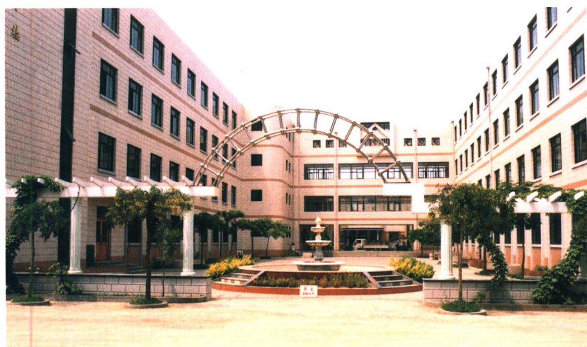
天津市第七中学综合楼庭院及入口广场
