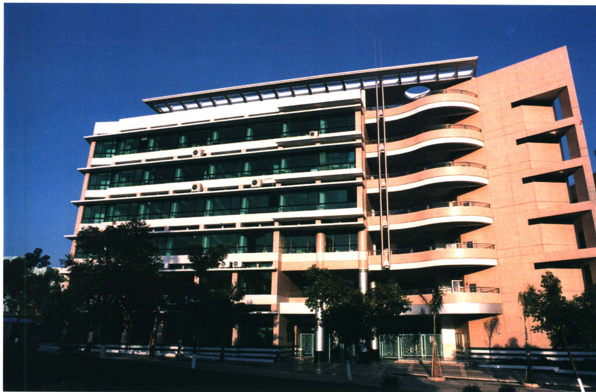
东莞理工学院综合实验楼
