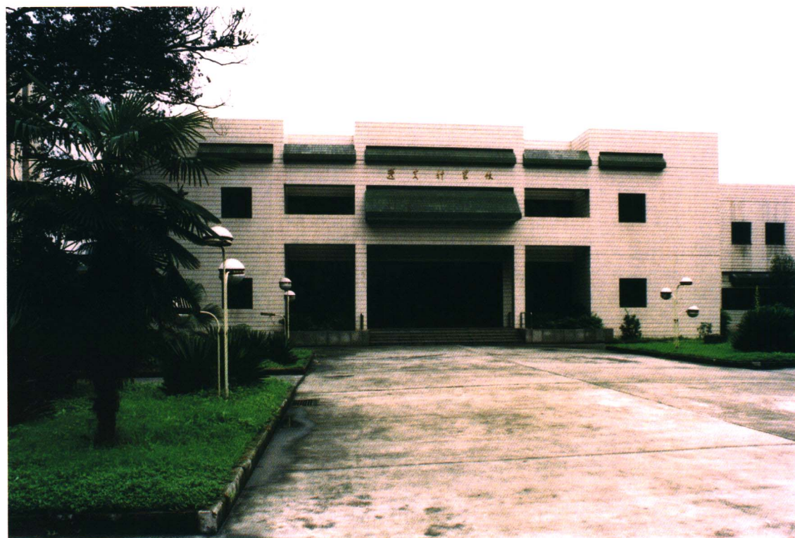
四川大学邵逸夫科学馆主入口外景
