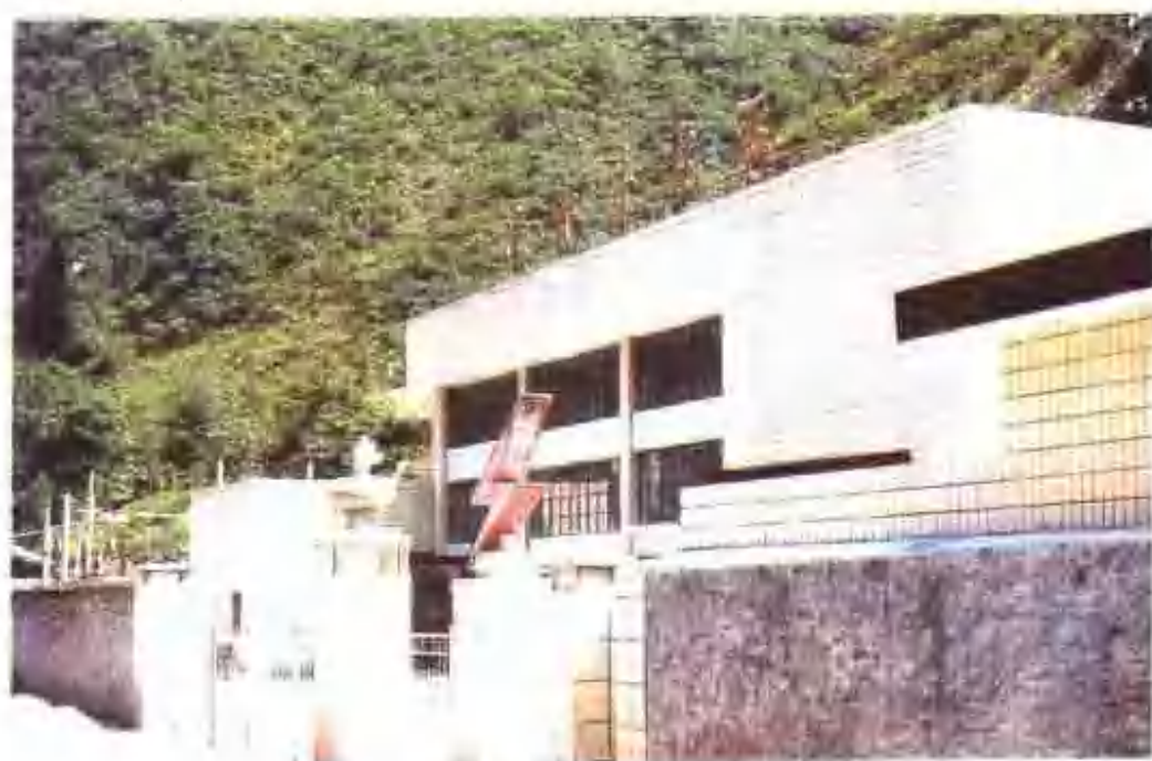
草坡凉水井电站
