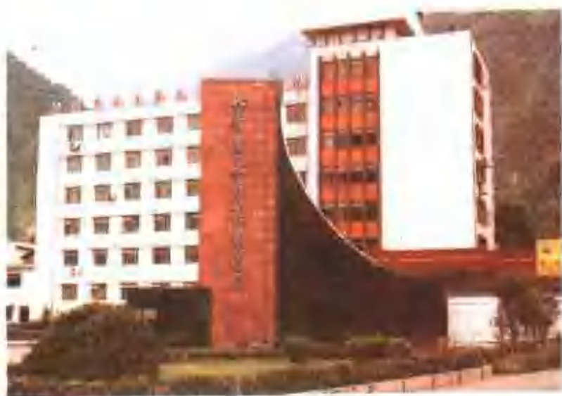
映秀湾水力发电总厂办公区
