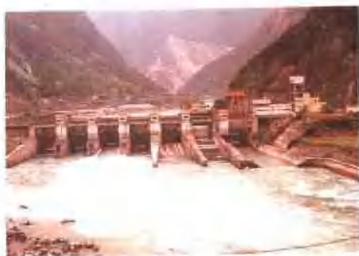
太平驿电厂拦河大坝
