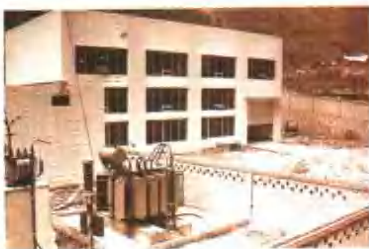
刚建成的七盘沟电站生 产区一角
